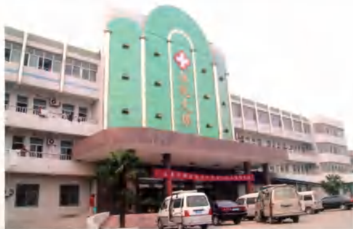
县人民医院住院部大楼 (摄于2004年8月)
