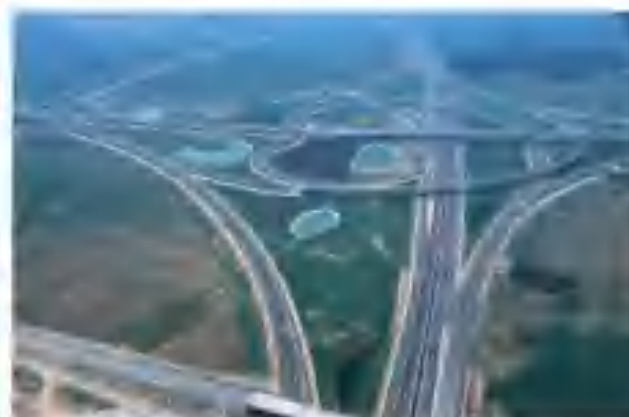
连霍、合徐高速公路在萧县朱圩子交汇（摄于2004年6月）
