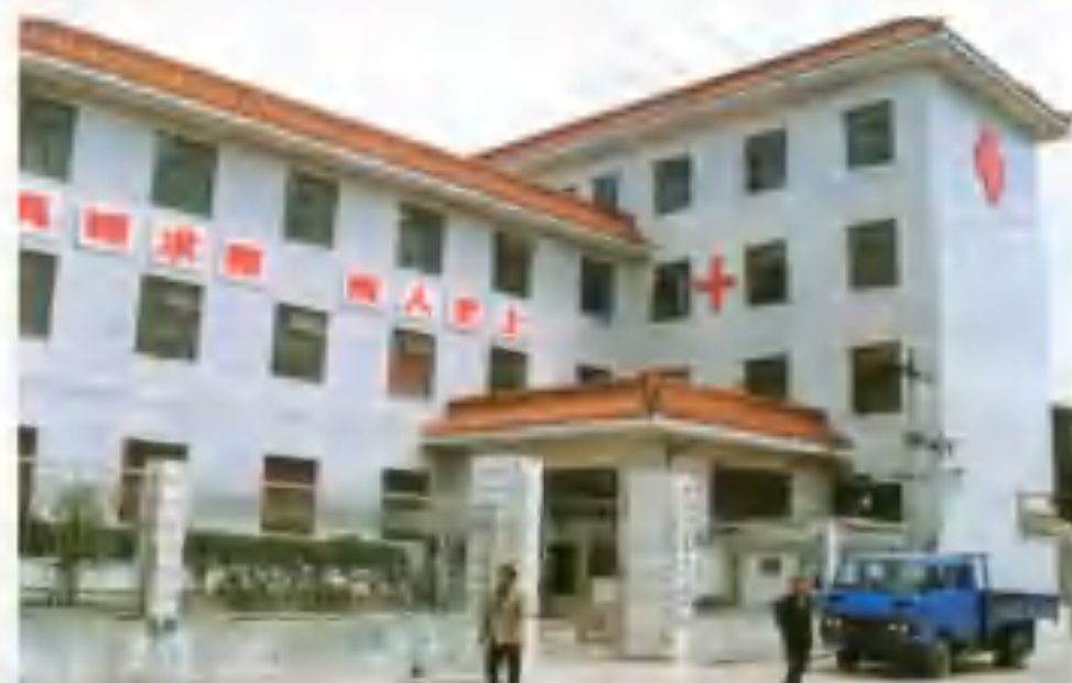
县中医院门诊大楼
