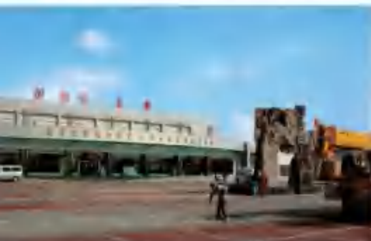
连霍高速公路萧县王寨服务区（摄于2005年12月）
