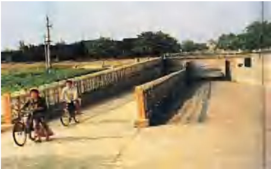
黄口铁路立交桥
