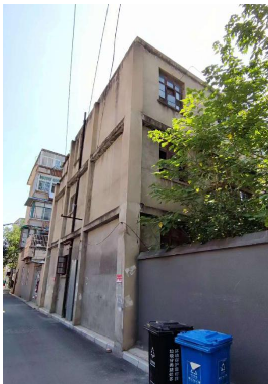
增设圈梁、构造柱
